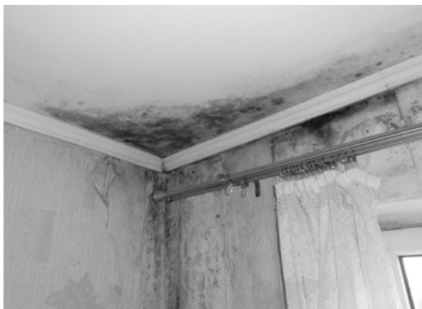
Рис. 1 – Характерные образования плесени на стенах и потолке жилого помещения в панельном здании.
